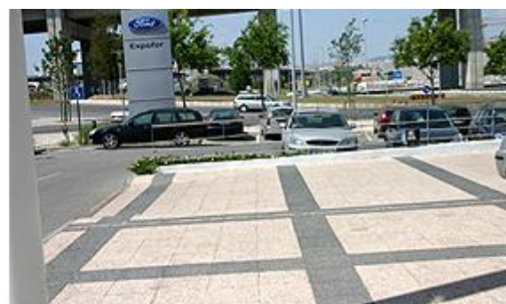
Modelo Pavimento piedra negra. Combinación en acera dos colores en formato 60 x 40 x 5
