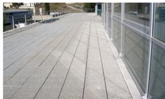
Pavimento técnico en edificio con modelo granito 60 x 40 x 5 y Apoyos elevados con regulación
